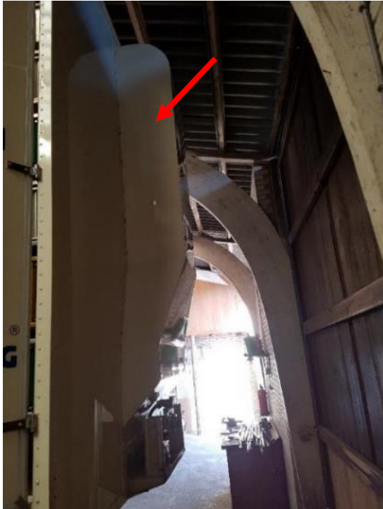
Ventilatiekoof om de lucht van boven naar beneden te transporteren
