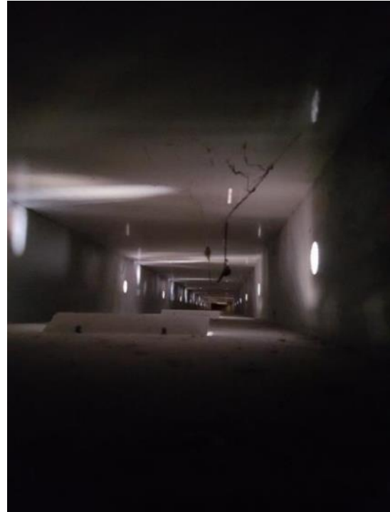
Foto genomen in het ventilatiekoof bovenin de wagen
