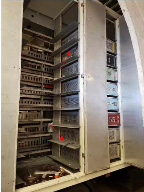
Locatie sensoren achterin (tussen de derde en vierde kolom van achteren)
