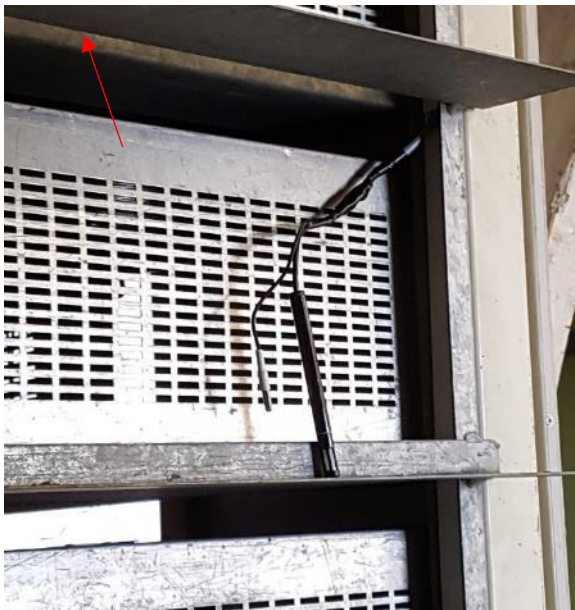
Ventilatiekoof om de lucht van boven naar beneden te transporteren
